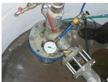
Trykprøvning af boring
