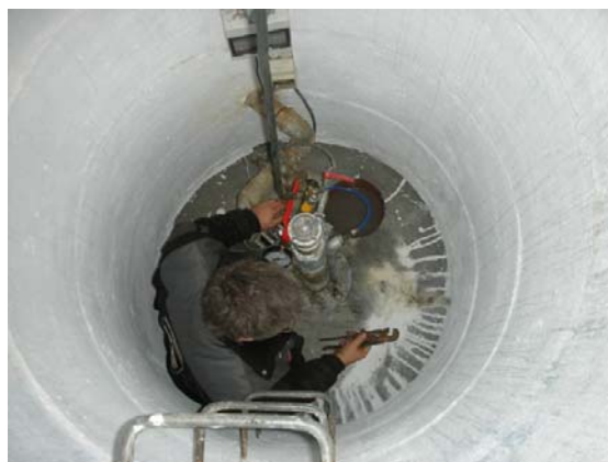
Trykprøvning af boring
