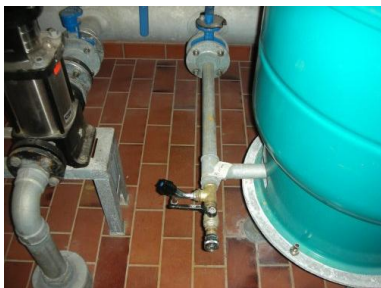
Prøvehane v/ membranhydrofor
