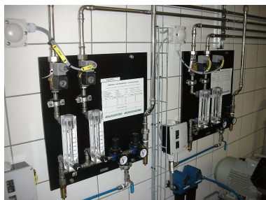
Luftstyring og luft kulfilter
