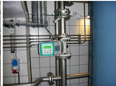
E-måler afgang trykfilter
