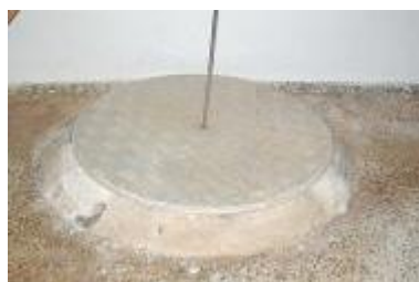
Nedgang rentvandstank med højdemåler.
