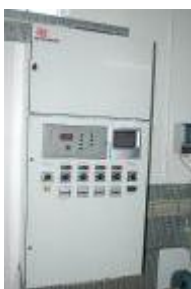
Frekvensstyring udpumpning
