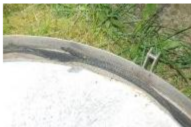
Defekt pakning - B Øst
