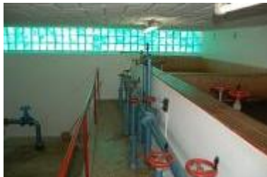
Filterafdeling med Åbne filtre
