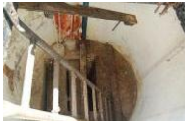
Nedgang rentvandstank med højdemåler.
