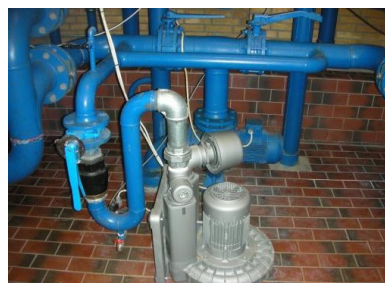
Skyllepumpe og kapselblæser
