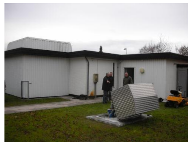
Thorning Vandværk, B1
