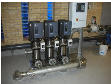
Udpumpningsanlæg
