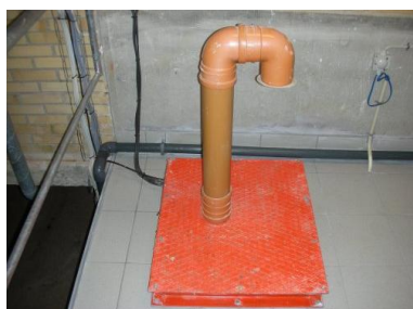
Nedgang til rentvandstank
