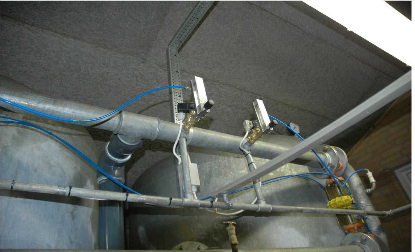
9 Styretavle til filterskyllning - den gule lampe med lys viser der pt udledes rensat filterskyllevand til recipient!
