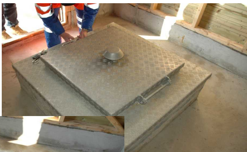
20 Mandehul til rentvandstanken - meget fin hygiejnisk stand p.g.a. af den beskyttelse overbygningen giver.
