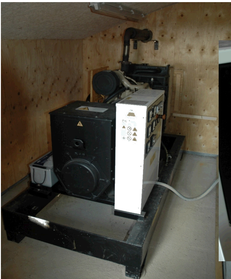
18 Nødstrømsgenerator, der kan trække hele vandværket inkl. alle indvindings- og udpumpningspumper
