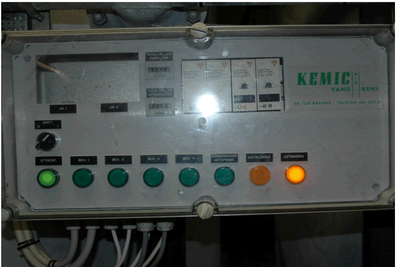
9 Styretavle til filterskyllning - den gule lampe med lys viser der pt udledes rensat filterskyllevand til recipient!
